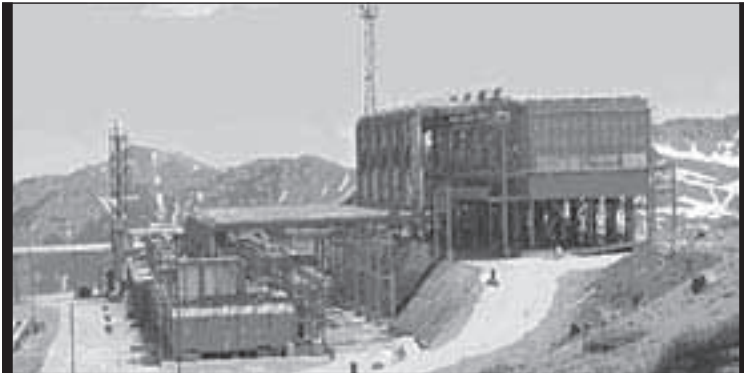
Верхне-Мутновская геотермальная электростанция (Камчатка) мощностью 12 МВт.
