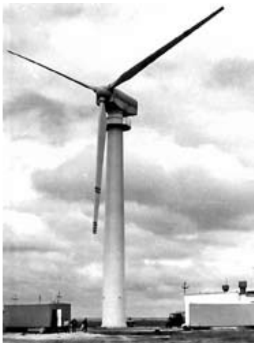
Рис. 8. Ветроустановка мощностью 250 кВт (разработчик — НПО «Ветроэн»)
