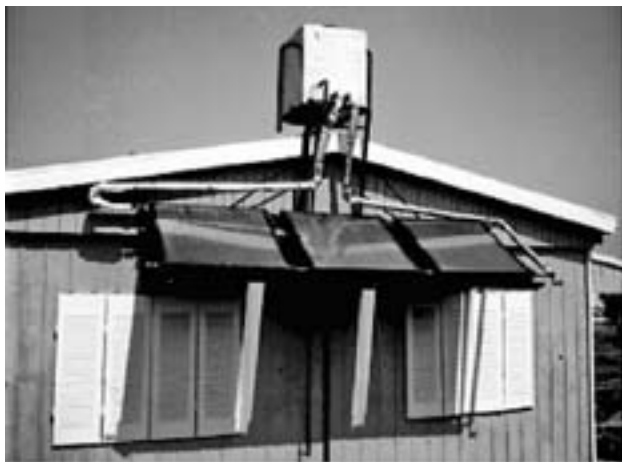
Рис. 3а. Система солнечного горячего водоснабжения в г. Анапа.
