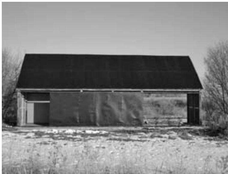
Рис 4. Солнечный коллектор для сушки древесины в Муравьевском парке устойчивого природопользования, Амурская область. Фото М. Колодиной
